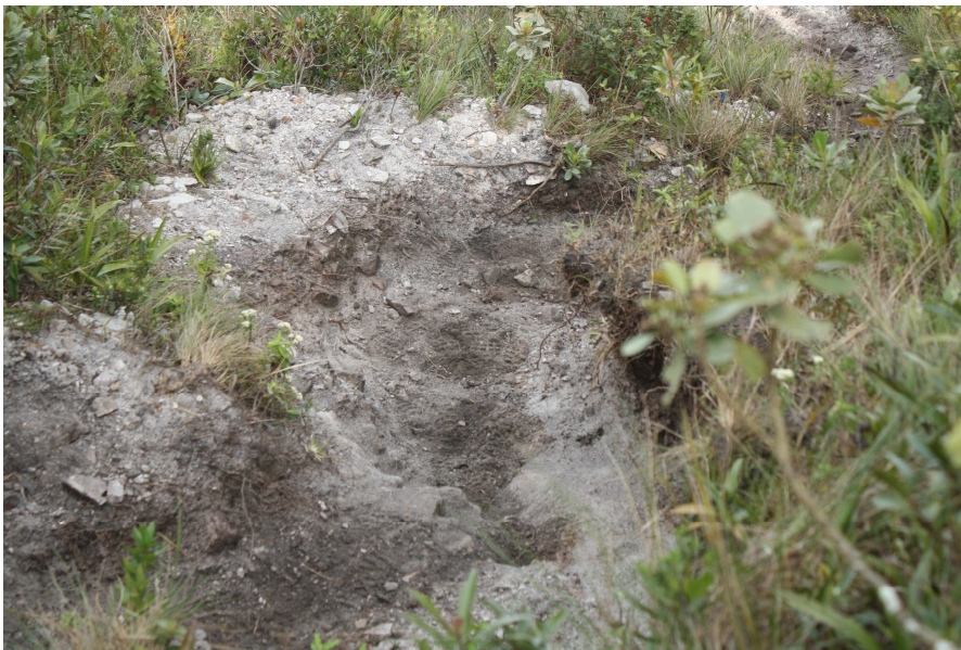
Figura 15: Processo erosivo no ponto CA14
